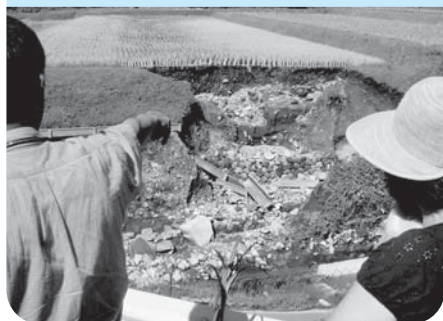
水路も崩壊した 赤松地区の水田
