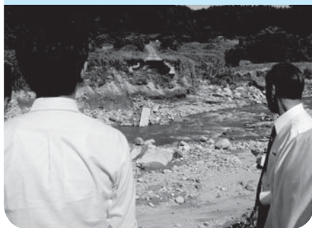
橋がすべて崩壊した 阿弥陀川の坊領東橋
