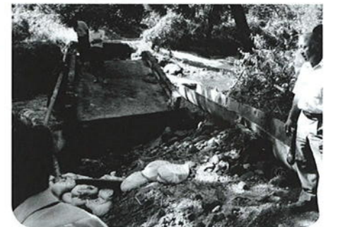
水道管も崩壊した 佐摩地区の新佐摩橋
