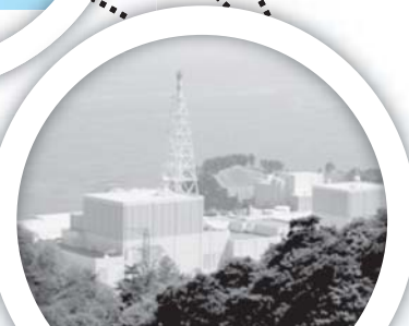
島根原子力発電所
