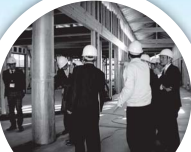
中山地区の保育園 建設現場
