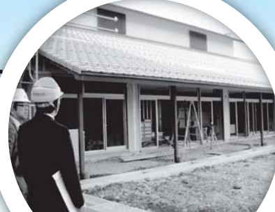
大山地区の保育園 建設現場
