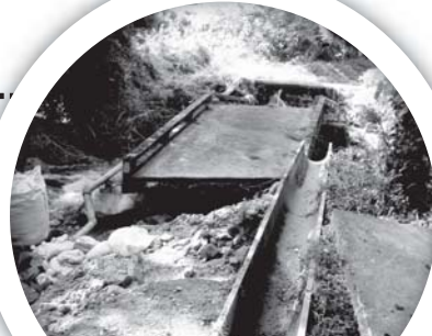
台風被害を受けた 新佐摩橋
