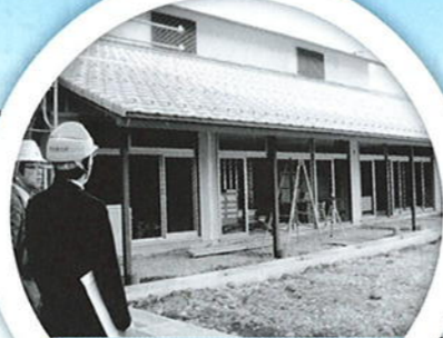
大山地区の保育園 建設現場
