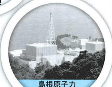
島根原子力 発電所
