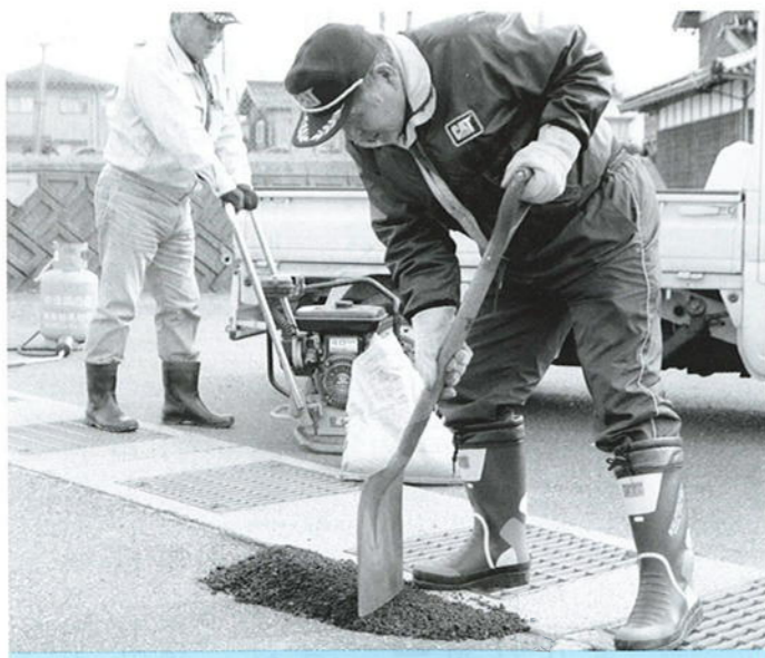
緊急雇用創出事業で町道を修繕
