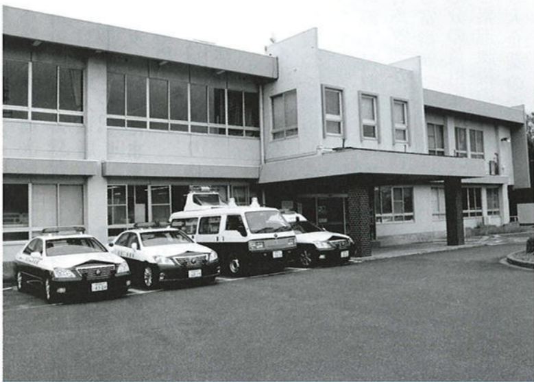
移転が予定されている八橋警察署
