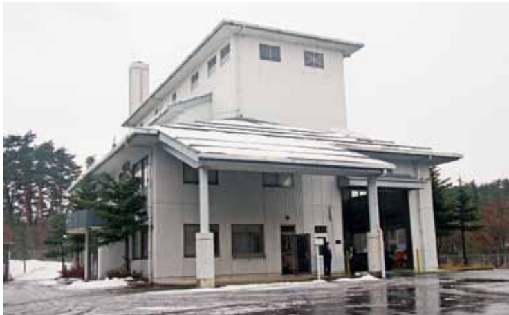
町内唯一の焼却施設となった名和クリーンセンター(新高田)
