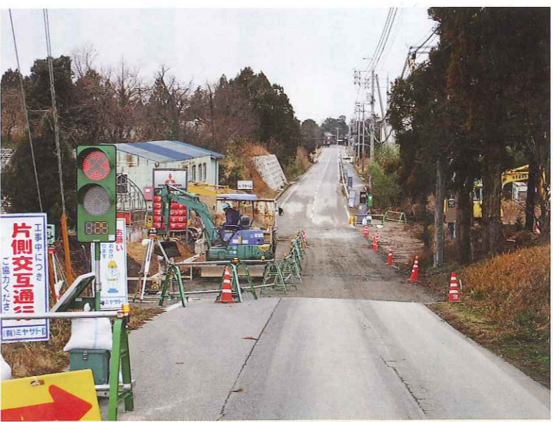
町道の拡幅工事
