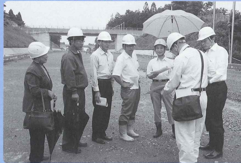
中山名和道路の工事現場
