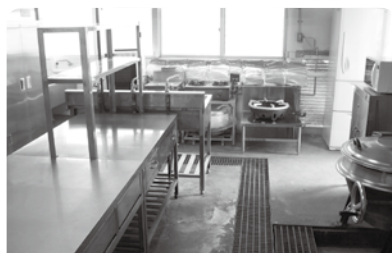
改修された食品加工室
