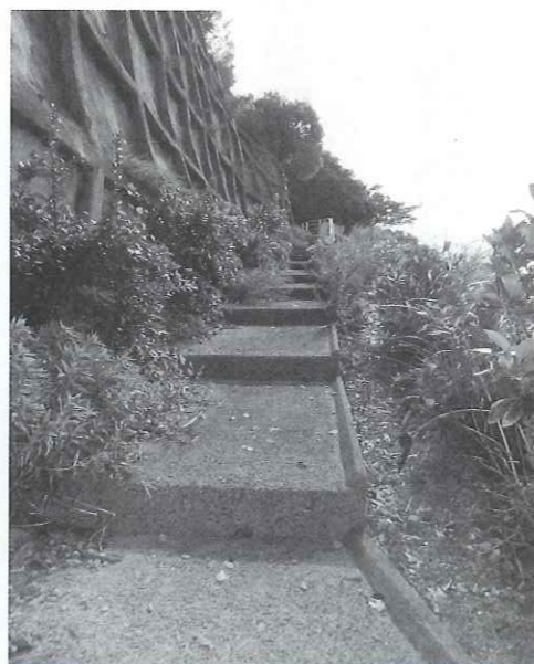
本庁舎裏手に続く避難路(御来屋)
