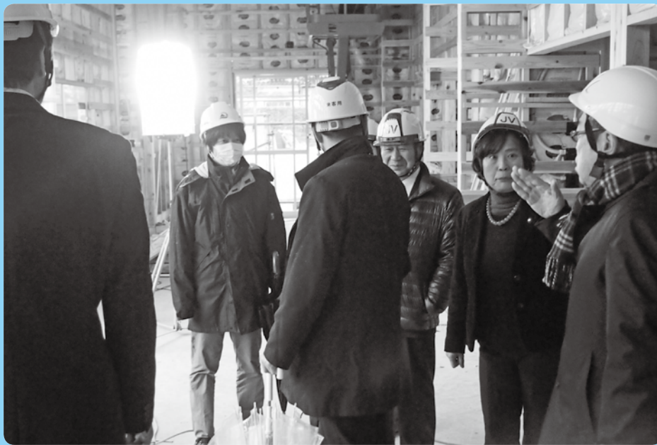
建設中の名和さくらの丘保育園
