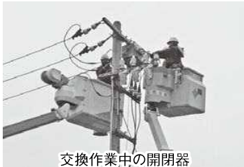
交換作業中の開閉器
