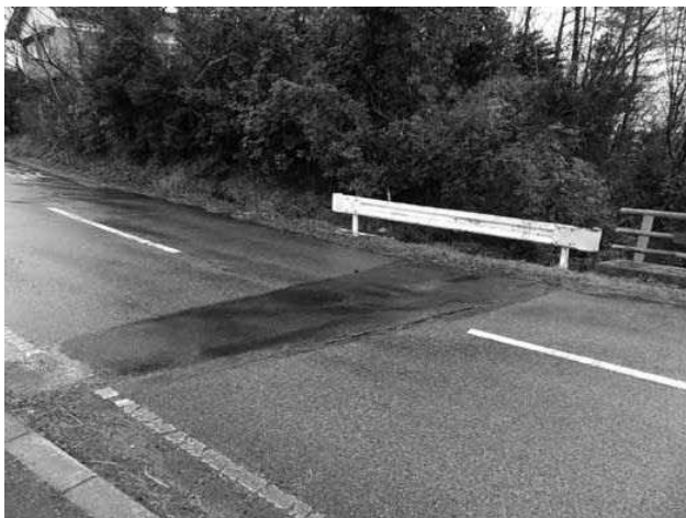
修繕された道路
