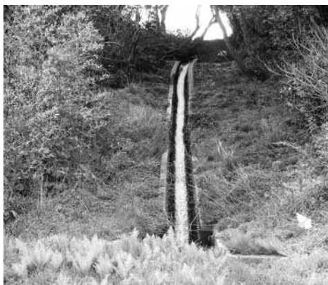
落差の大きい水路
