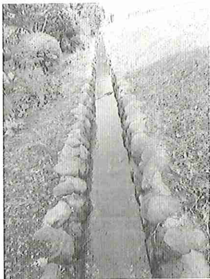
写真右側の石積護岸、乱積、安山岩 （場正免井手沿い）
