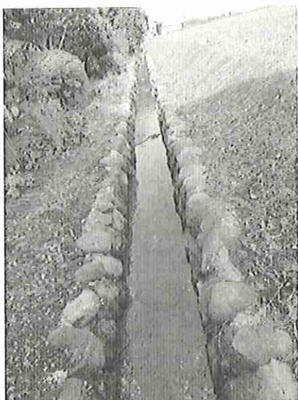
写真左側の石積護岸、乱積（安山岩） （場正免井手沿い）
