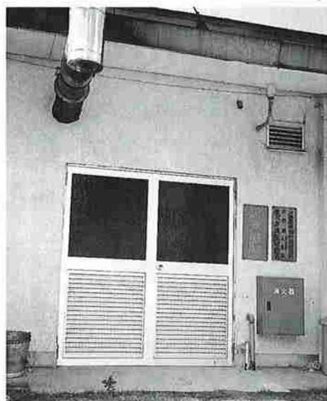
検査の結果、アスベストは使用されていなかった(所子保育所の機械室)
