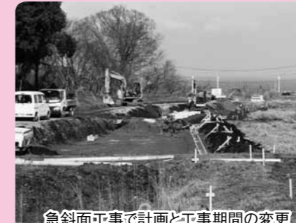
急斜面工事で計画と工事期間の変更
