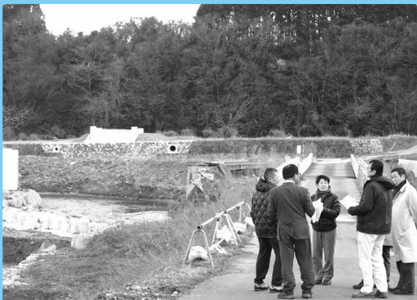
坊領向原線の阿弥陀川橋予定地
