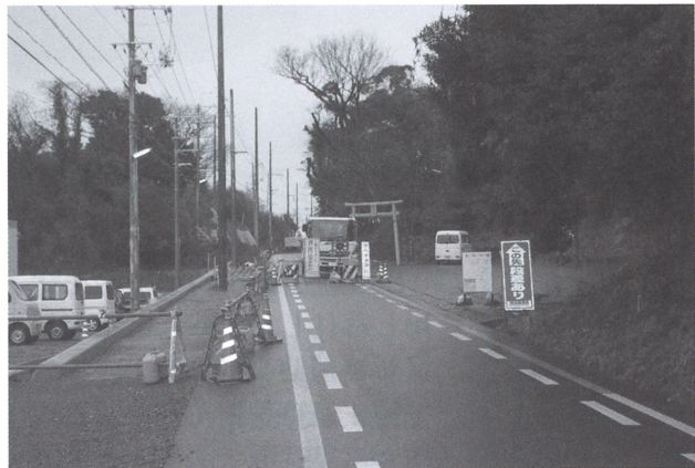
県道歩道の改良工事（松河原）
