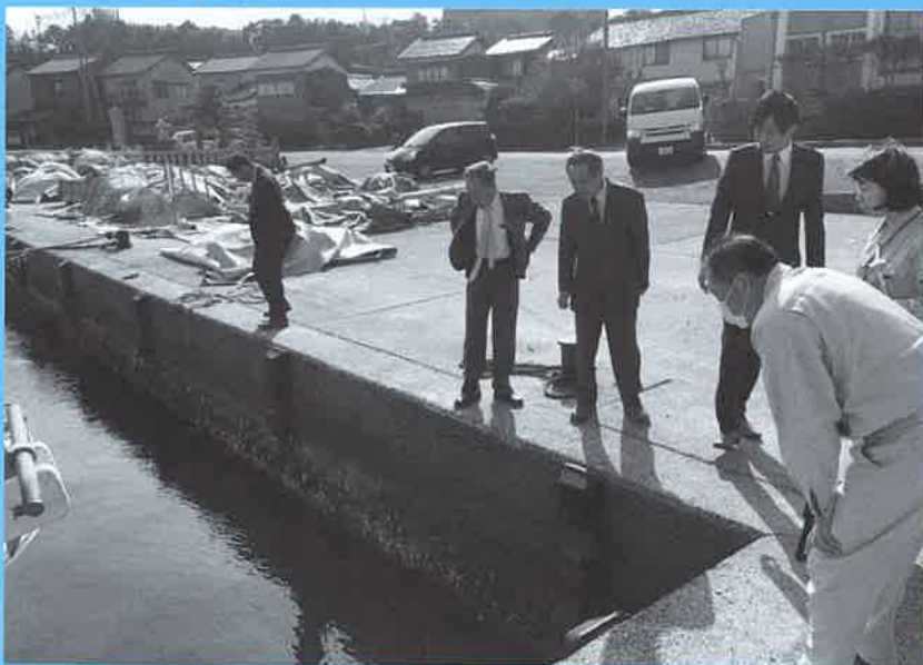
御来屋漁港の浚渫現場
