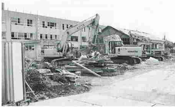
解体中の名和小学校
