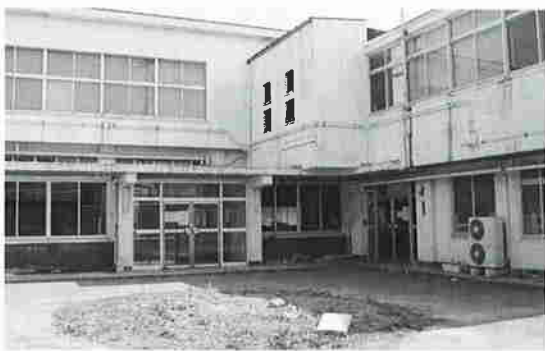
取り壊しを待つ旧大山町役場
