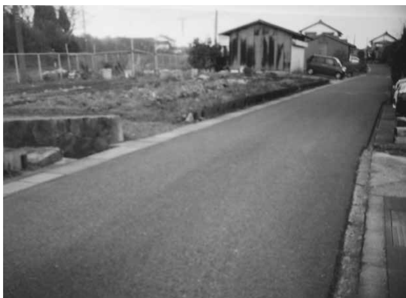
下市駅前の浸水被害地域
