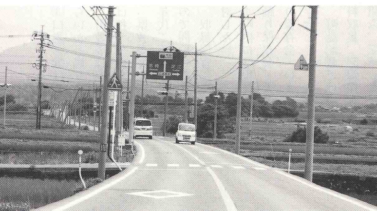
早急な整備が必要な大山道路
