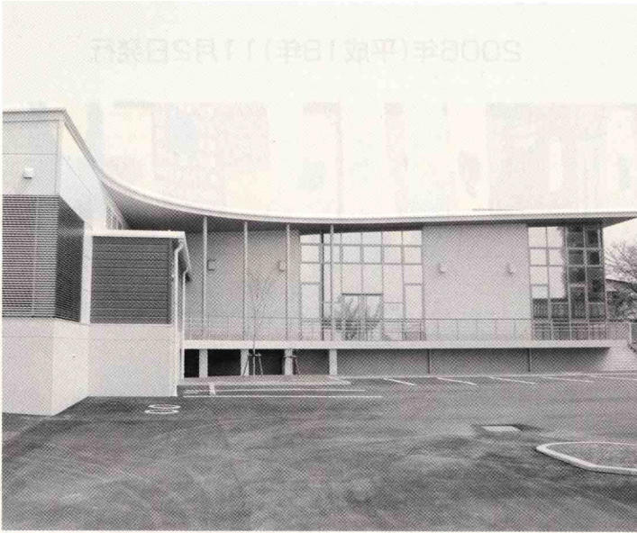
新築された大山給食センター
