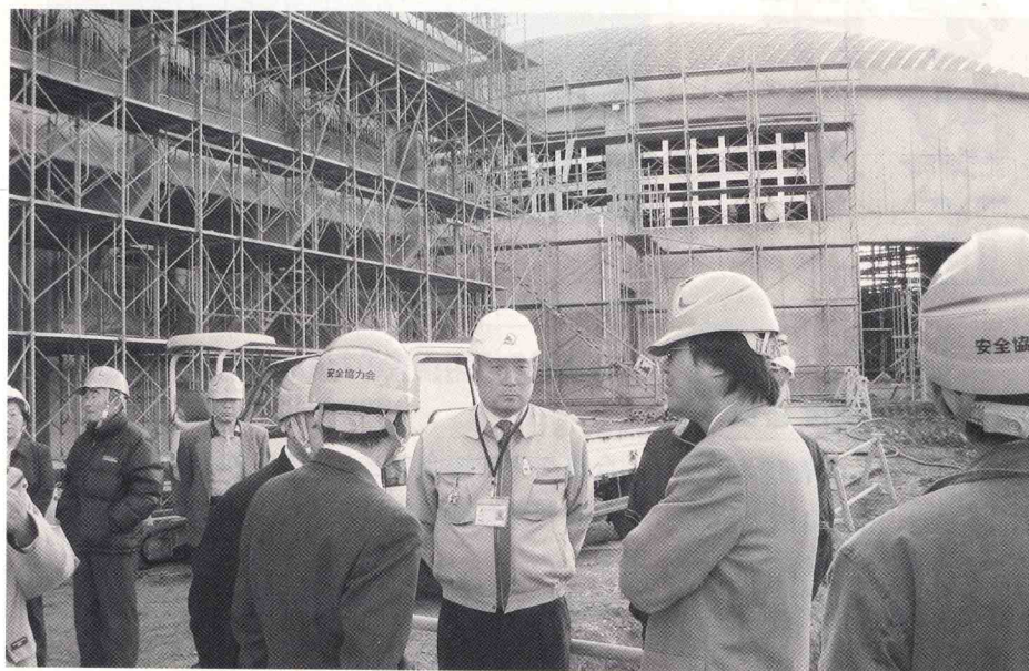
名和小学校建設現場を視察。後ろの円形屋根は体育館
