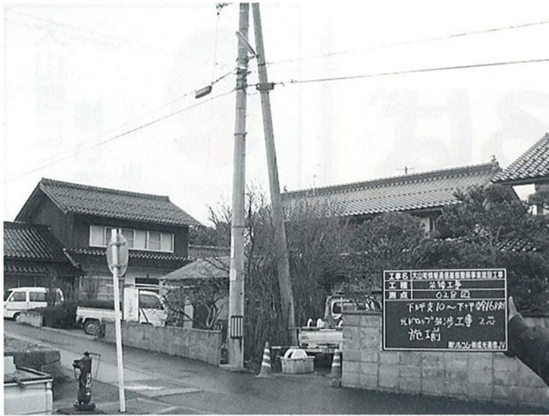
情報通信基盤整備工事の様子
