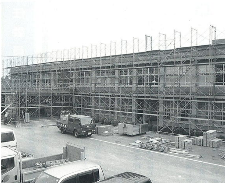
着工された中山小学校大規模改修工事
