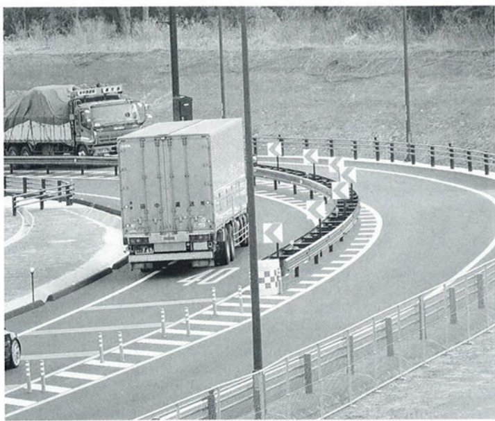
開通した山陰道名和インター付近
