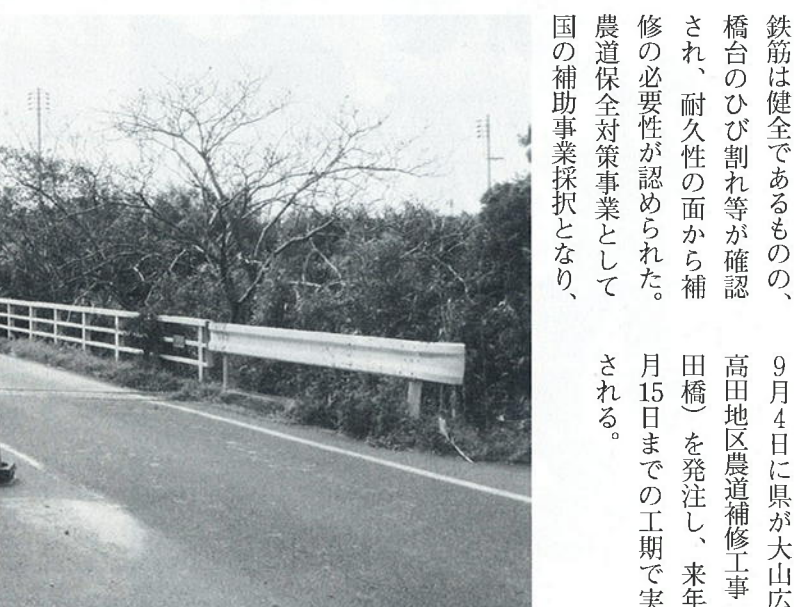
工事がはじまった高田橋
