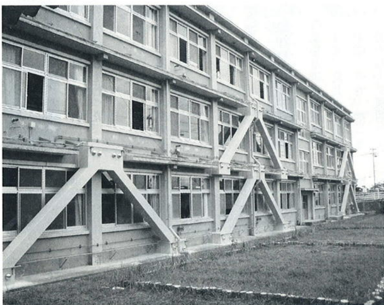
完了した名和中耐震補強工事
