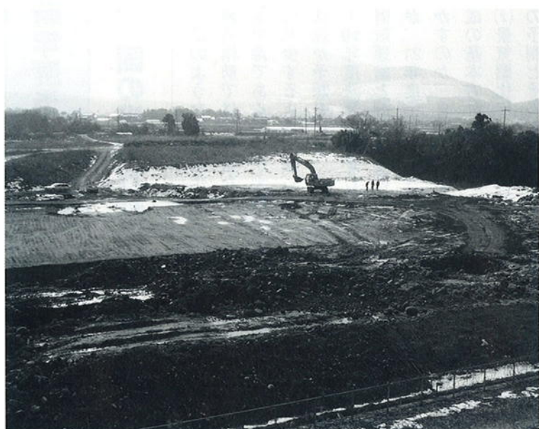
造成工事中の所子工業団地
