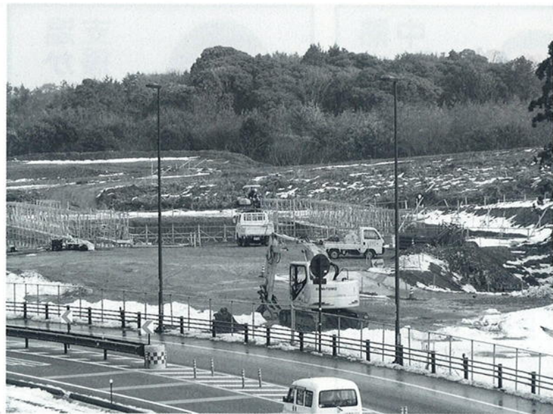
不況の中、建設業の雇用不安も心配される
