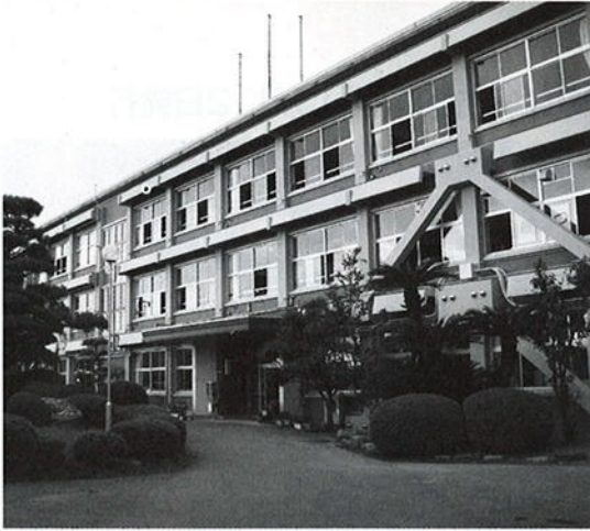
完了した大山中耐震補強工事
