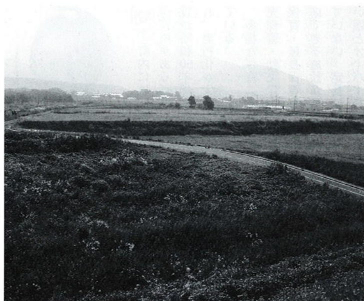
平成21年6月造成工事完成の所子工業団地
