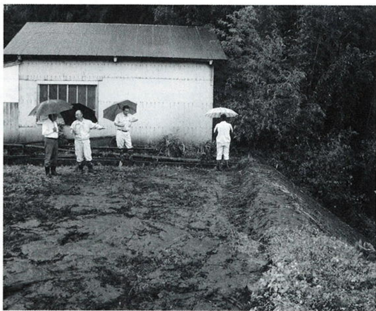
崩壊した水田の原形復旧を行った
