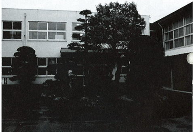
大規模改修を計画中の大山小学校
