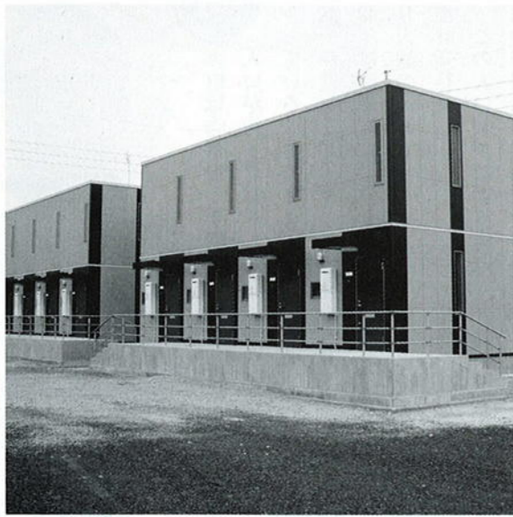
中山地区に完成した若者向け住宅
