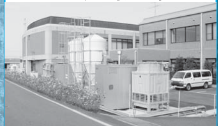
中山支所ペレットポイラー導入工事
