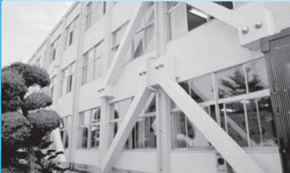
大山西小学校耐震補強および大規模改修事業
