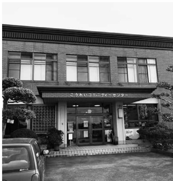
地域に根差す活動を支える高麗分館
