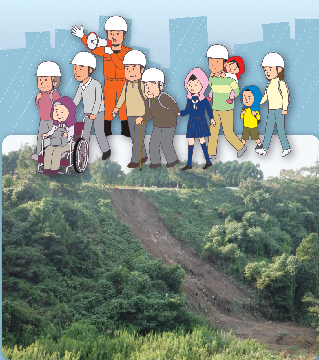
〔平成30年度台風24号被災、町道二本松横断4号線（路肩崩壊）〕
