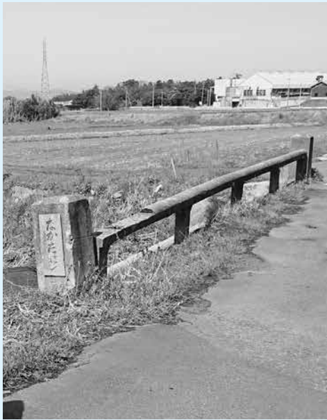
修繕予定のながたはし
