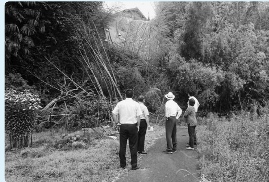
集中豪雨による土砂崩れ
