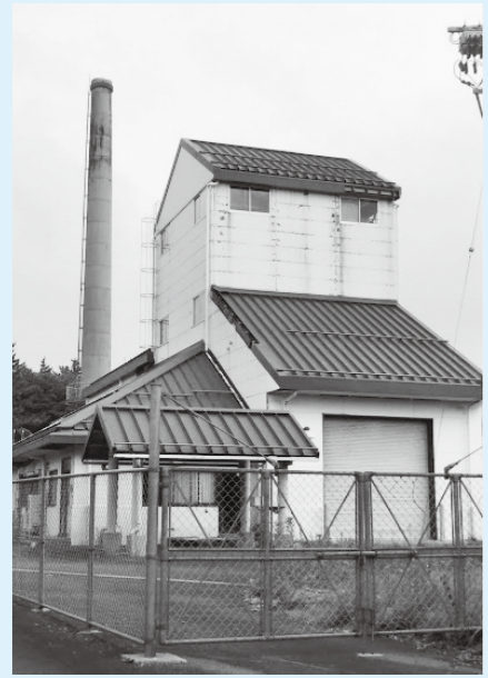
解体される清掃センター
