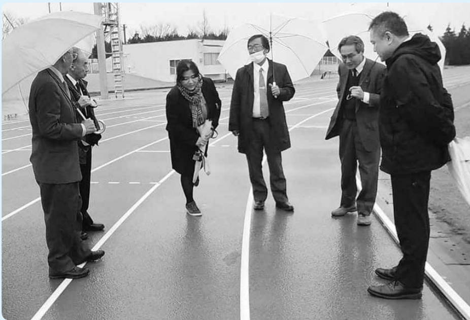
トラックの修繕箇所を確認
