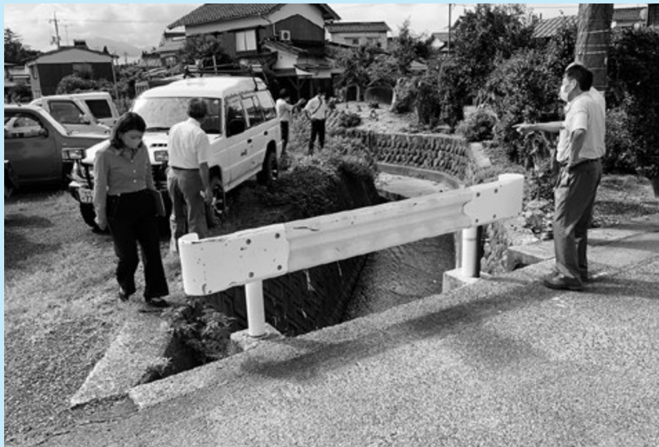
下市駅付近の排水路
