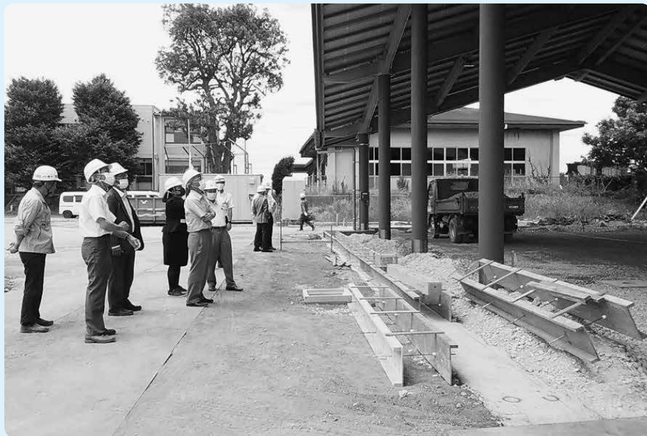
着々と建設が進むこうれい上屋付多目的広場
