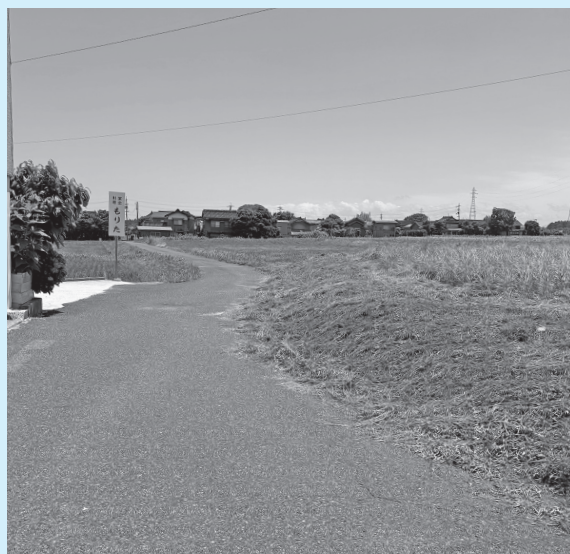
町営にて中山口駅付近に新規造成
