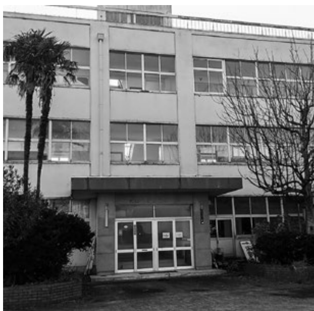
一部解体が決まった小学校
