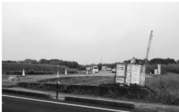
工事中の中山インター線
