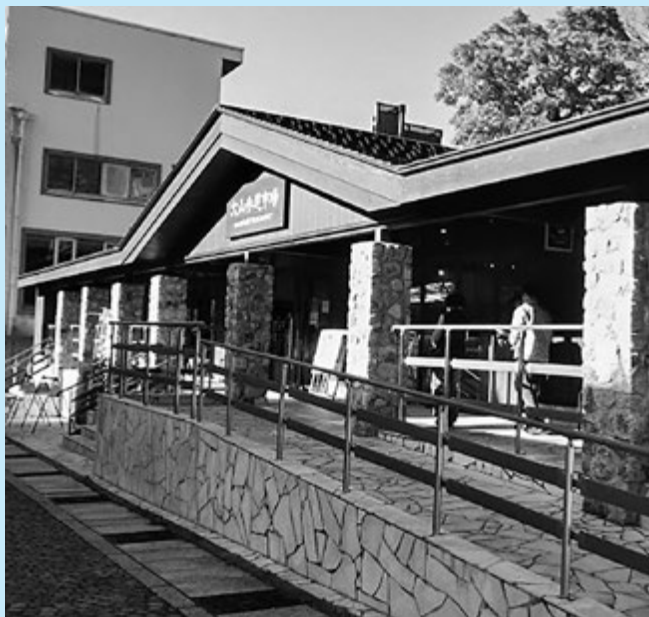
町のPRと西陽対策で整備
