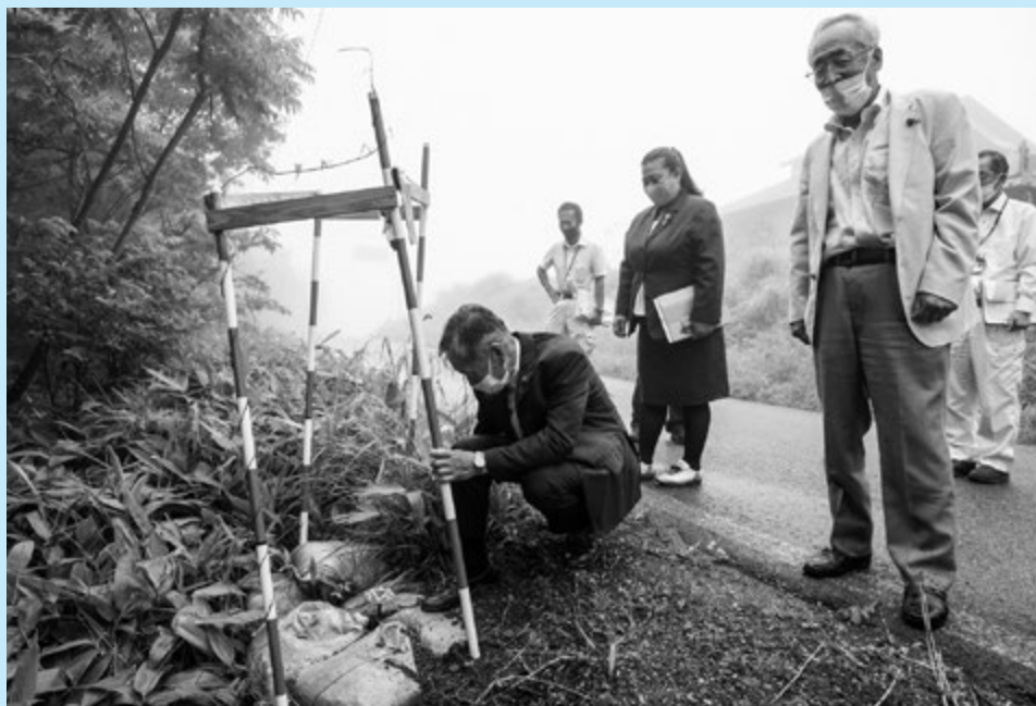
水道管破損の修理状況を視察（香取）
