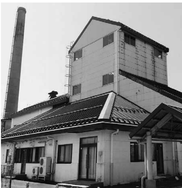
解体される中山清掃センター
