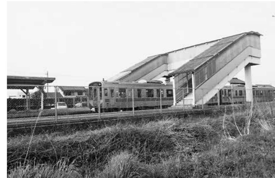
整備予定の下市駅南側
