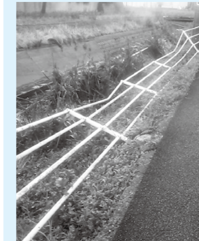
破損したガードレール
