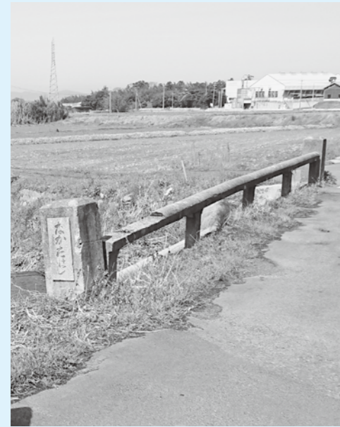
修繕予定のながたはし
