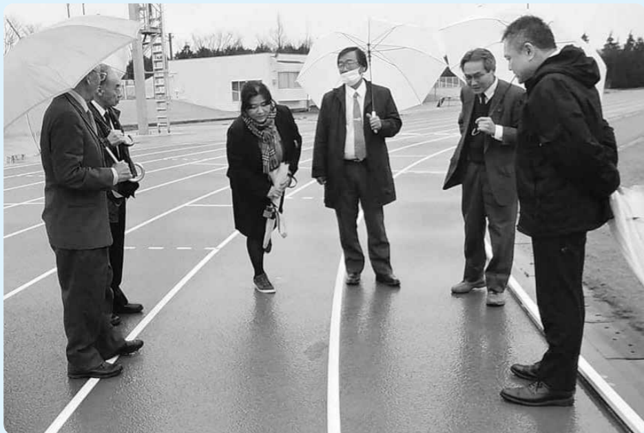
トラックの修繕箇所を確認
