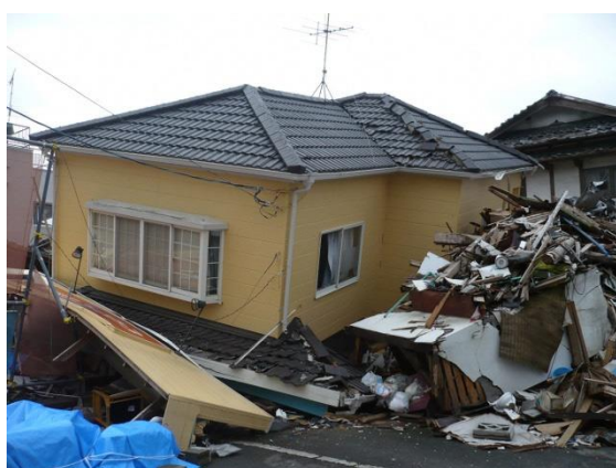
平成 28 年熊本地震被害状況
